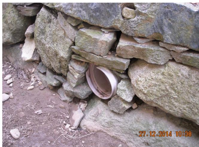
Foto 4, 5 - tubazione di scarico dai terreni agricoli al canale derivatore
